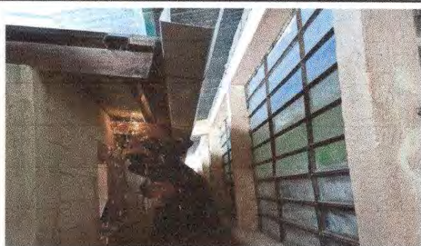
Foto 5: sustitución de canales de metal.
