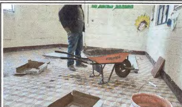
Foto 14: Sustitución de piso de granito
