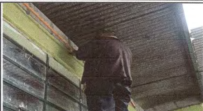
Foto 13: Sustitución de ducto eléctrico y accesorios
