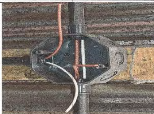
Foto 8: sustitución de plafoneras
