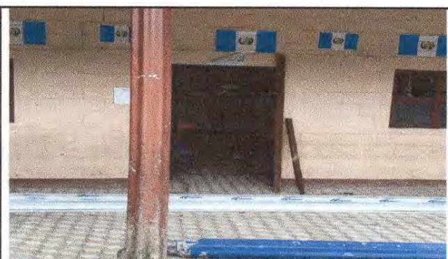
Foto 3: sustitución de puerta
