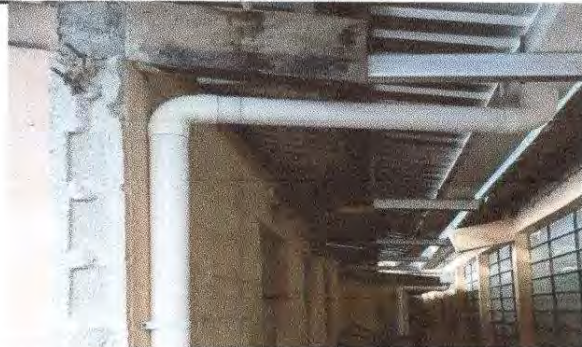
Foto 6: bajadas de agua pruvial de metal por tubo PVC
