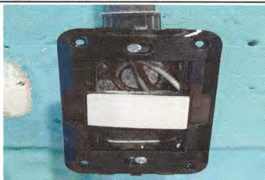
Foto 9: sustitución interruptores simples
