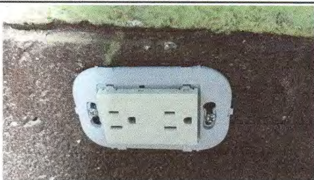
Foto 11: sustitución de tomacorrientes dobles
