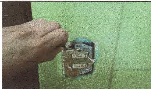
Foto 10: Sustitución de interruptores dobles
