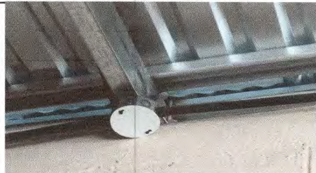
Foto 12: Sustitución de cableado eléctrico
