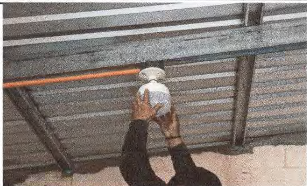
Foto 7: Sustitución de focos ahorradores
